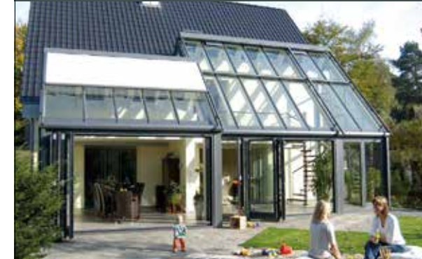
| Montage | Wartung | Sanierungsberatung
